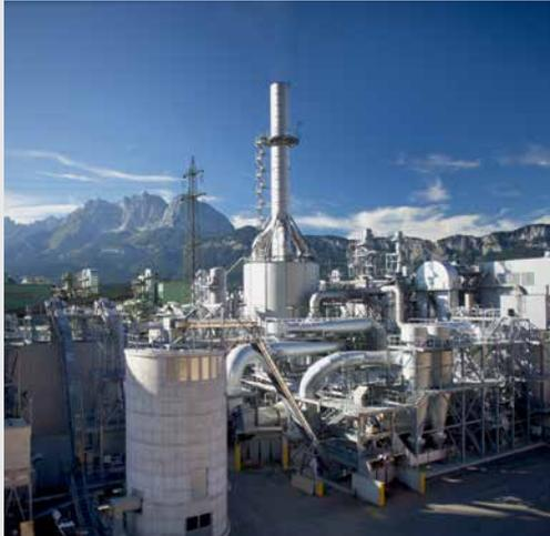
Der Holzrockner im EGGER-Werk St. Johann dient dank ausgeklügelter Abluftreinigung als saubere erneuerbare Wärmequelle für die umliegenden Gemeinden. Die Anbindung an das Fernwärmenetz gewährleistet, dass selbst der Energiegehalt von stofflich nicht nutzbaren Holz- und Produktionsabfällen voll ausgeschöpft wird.
